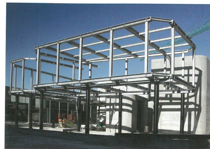
Struttura in acciaio di un blocco direzionale.
